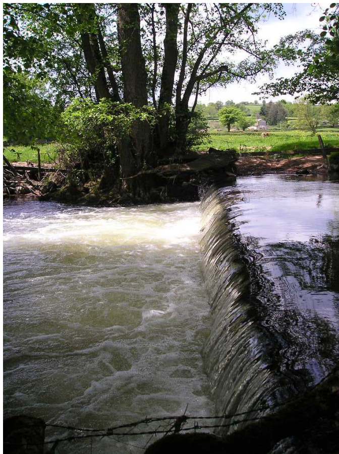
Vue de l'ouvrage « dit du stade »
