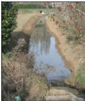
Travaux de recalibrage réalisés sans déclaration
