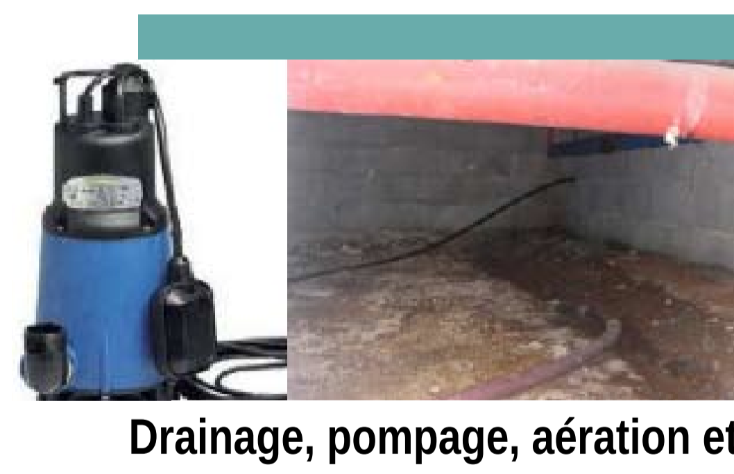
Drainage, pompage, aération et visibilité du vide sanitaire
