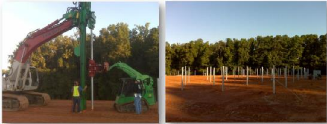
Installation de pieux battus. (Source : ENGIE Green)
