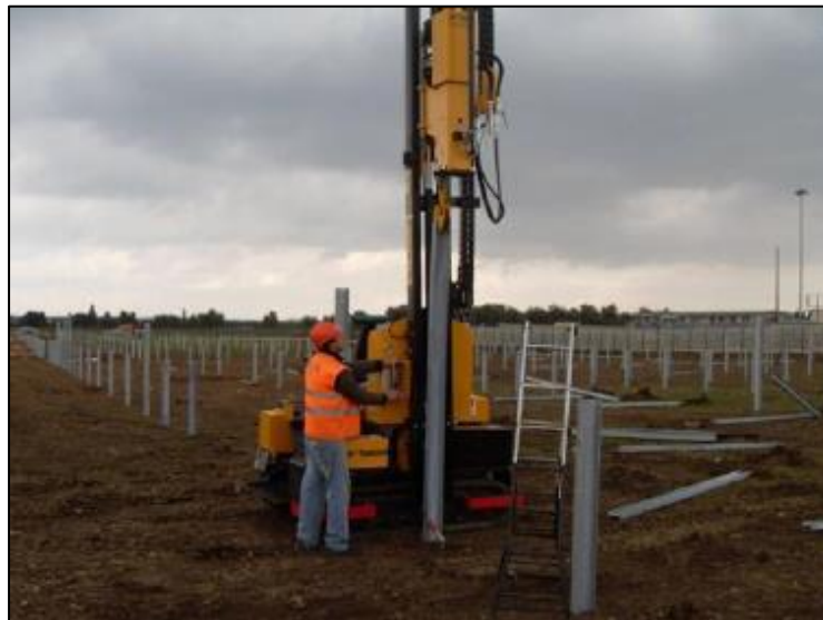
Exemple de pieux battus (Source : ENGIE Green)
