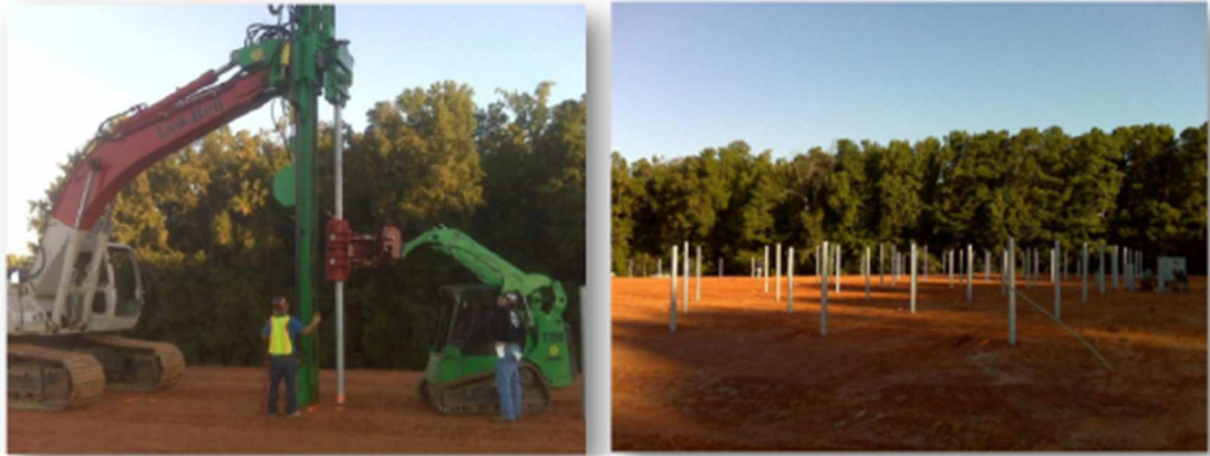
Installation de pieux battus. (Source : ENGIE Green)
