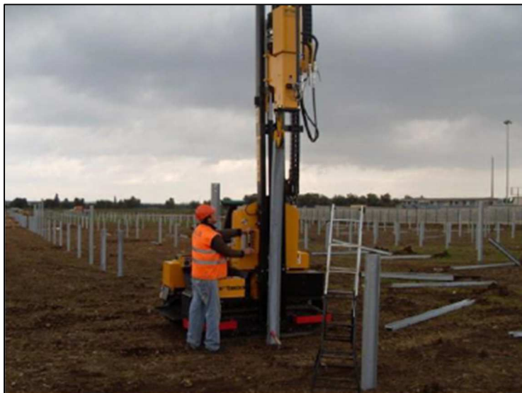
Exemple de pieux battus (Source : ENGIE Green)
