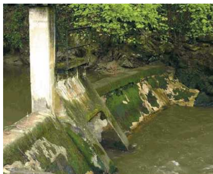
Le seuil de l'usine en 2007, avant démantèlement.
